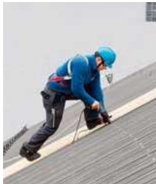
Regel 3 Durchbruchssichere Dachflächen.
