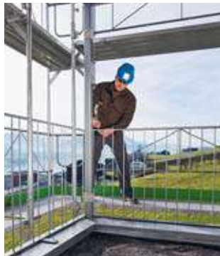
Regel 2 Gerüste täglich kontrollieren.
