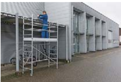
1 Ist kein Fassadengerüst möglich, eignen sich oft Rollgerüste.
