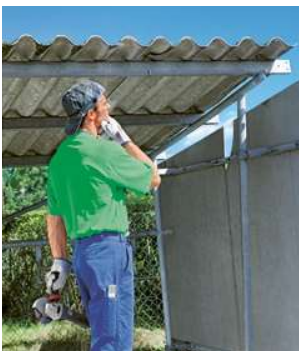
Regel 9 Asbeststaub vermeiden.
