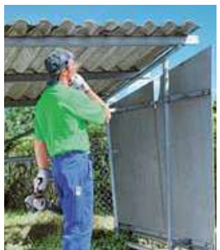
Regel 7 Asbeststaub vermeiden.
